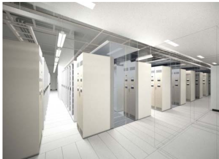
データセンター内部
